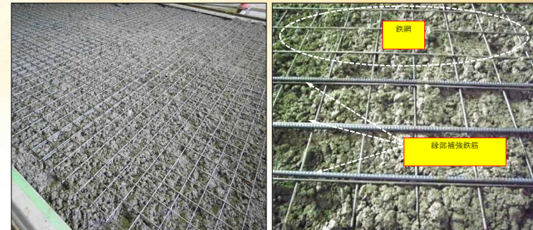
鉄網の設置状況
